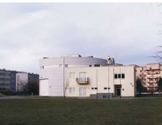
Budynek nowoczesnej wirówki przeciążeniowej
