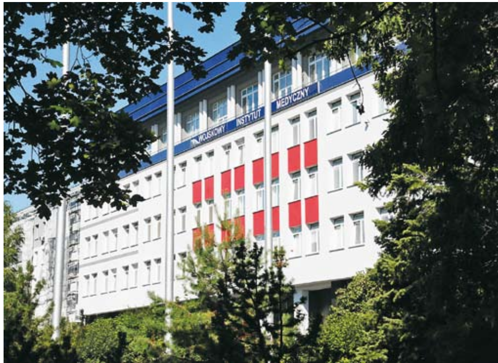
Budynek Szpitala WIM, 2014 r.
