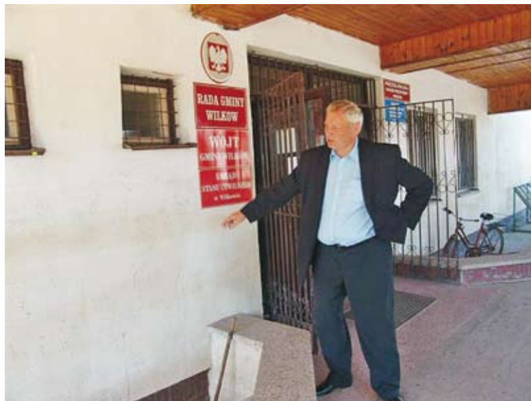
Pan Gajek pokazuje linię zatopienia budynku gminy Wilków
