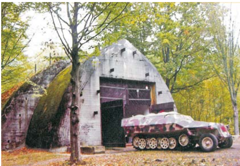
Bunkier w Konewce – „Anlage Mitte”
