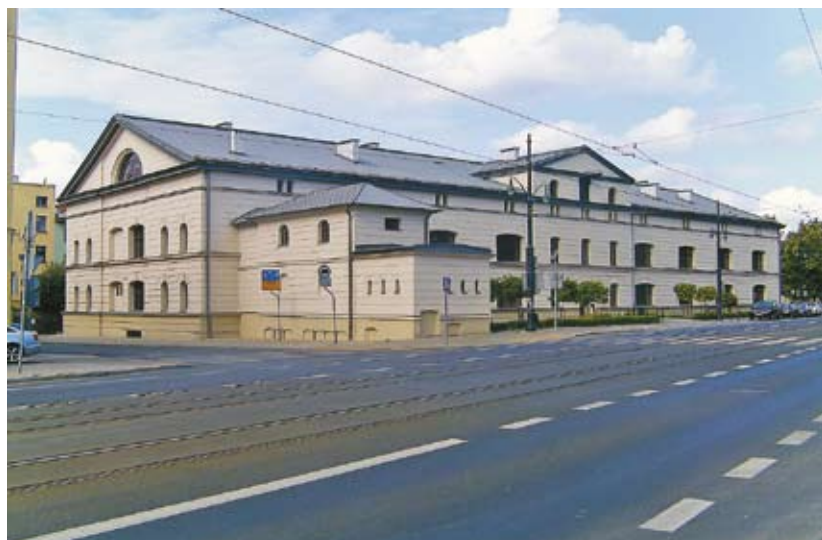
Główny budynek szpitala, obecnie przychodni po kapitalnym remoncie
