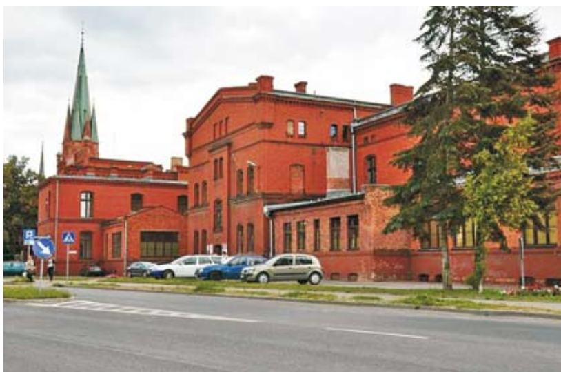
Budynki od strony ul. Dąbrowskiego
